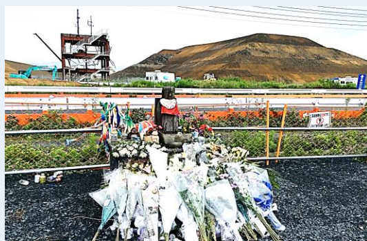
南三陸町防災対策庁舎とかさ上げの盛土
