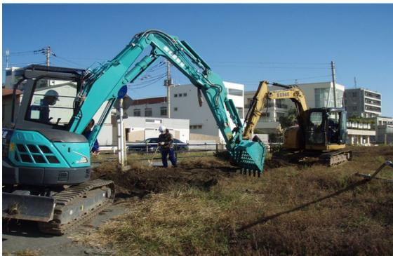
写真6 重機による整地作業
